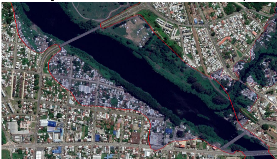
Imagen 4: Área inundable desbordes Rio Rahue sector Rahue Bajo.
