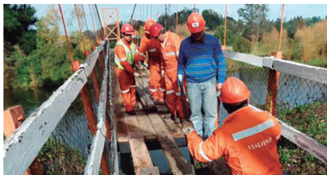
Alianza entre municipio y Vialidad permitió reparar esta estructura.
