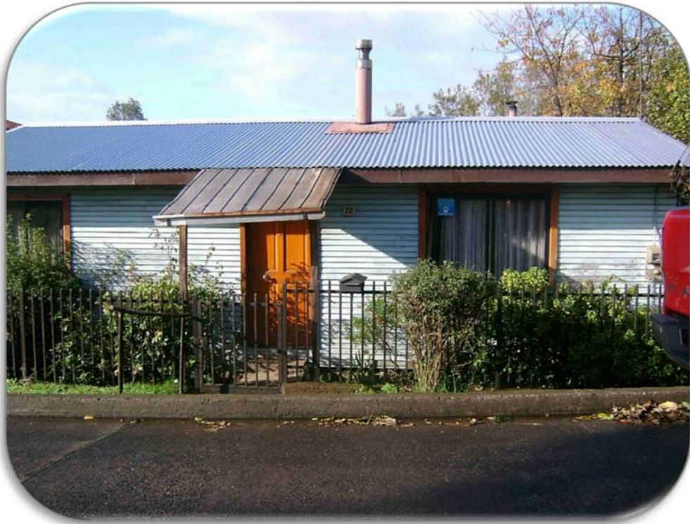
MEJORAMIENTO TÉRMICO EN CALLE JUAN SCHURMANN N°72
