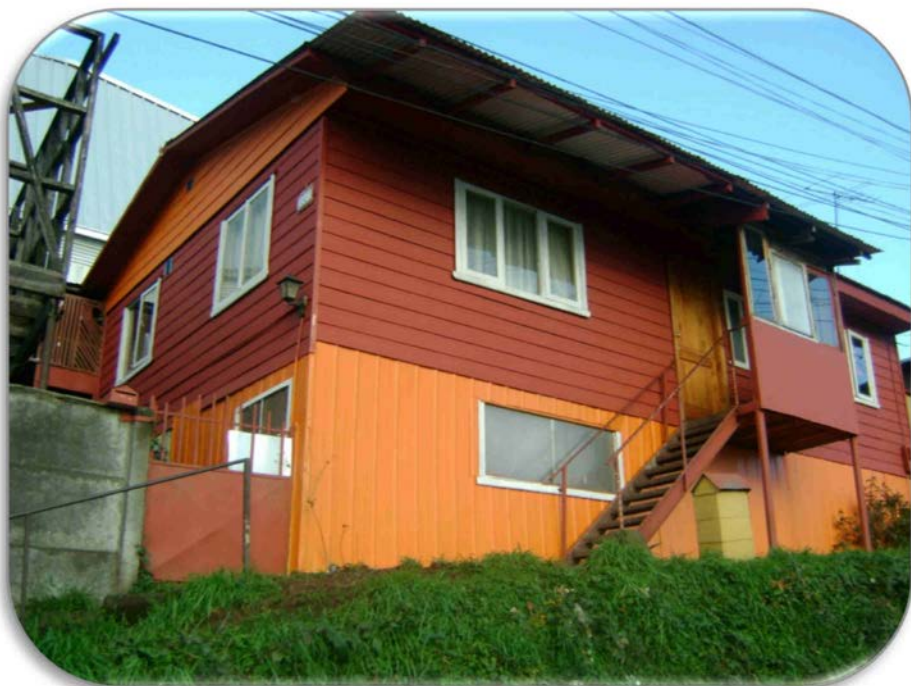
MEJORAMIENTO TÉRMICO EN PASAJE SAN RAMÓN N°43
