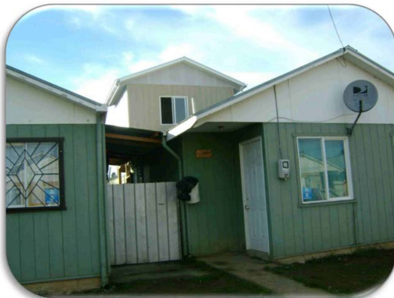
DORMITORIO EN 2° PISO PASAJE LOS LAGOS N° 2297
