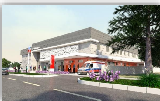
Fachada SAR CHUYACA Av. 18 de Septiembre
